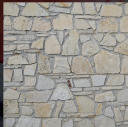
Maçonnerie de moellons
